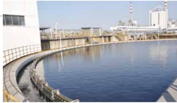
目前王子制浆废水处理站采用“预处理+纯氧曝气+三级化学处理+AOP（高级氧化处理，备用）”工艺。制浆系统产生的生产废水与生活污水经处理站处理后达到《制浆造纸工业水污染物排放标准》（GB3544-2008），接入由南通市开发区建设运营的中水（再生水）回用示范工程。据开发区介绍，经深度处理后获得的中水（再生水）水质非常好，开发区内相关企业使用后评价很高，大大提高了水资源的利用率。
