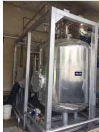
江苏王子制纸有限公司蒸煮工段增加再沸器设备回收黑液热能
